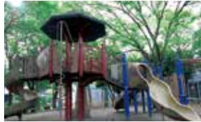
公園遊具改修
