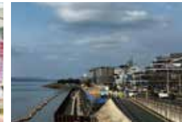
市役所～宍道湖温泉前護岸改修
